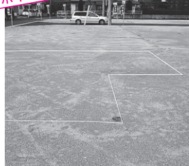
地縄張りは建物や柱の位置、基礎の高さなどを決める重要な作業
