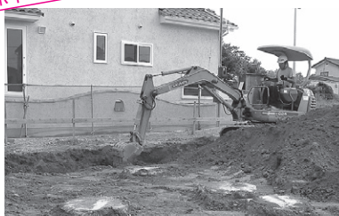
基礎の大きさと形状に合わせ、「バックホー」(掘削機械)を使い地面を床堀りしているところ
